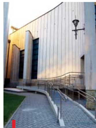
Podjazd ułatwi niepełnosprawnym życie
